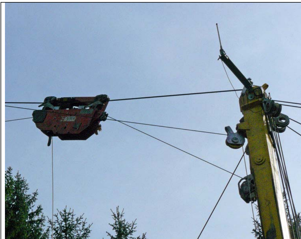
Chariot et sommet du câble mat avec l'antenne de radiocommande
