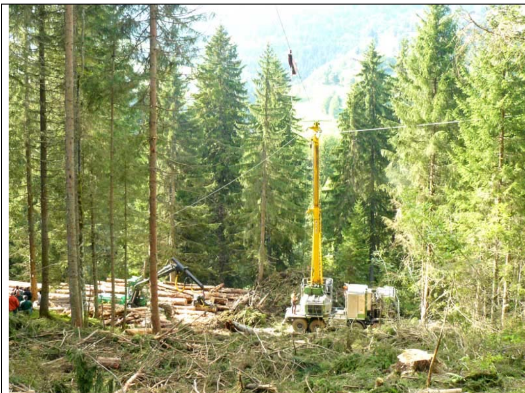
Chantier de réception, ébranchage, tri et cubage, vue 1
